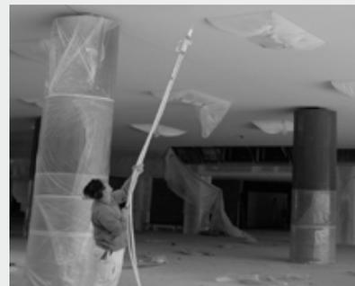
6. Nach Trocknung der Vliesflächen KRAFT Akustikputz Picco S zweischichtig aufspritzen. Wartezeit zwischen den Arbeitsgängen einplanen
