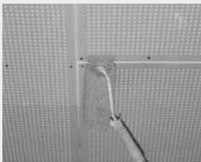
1. KRAFT Isogrund mit der Rolle auftragen
